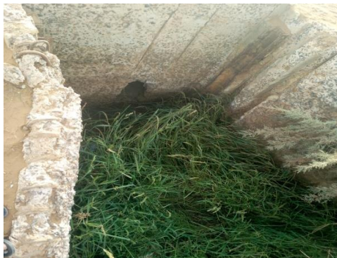
Photo 3 : Canal d'eau à Mboundoum
